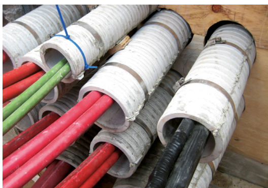
Delená pažnica HRD FU2 G pred betonážou
