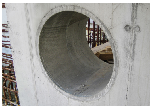
Nedelená pažnice HRD FU2 po betonáži
