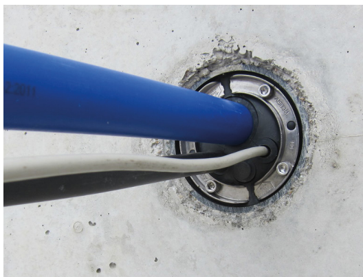
Tesnenie HSD 100 EWD 1x24-44+4x7-12 v jadrovom vrte
